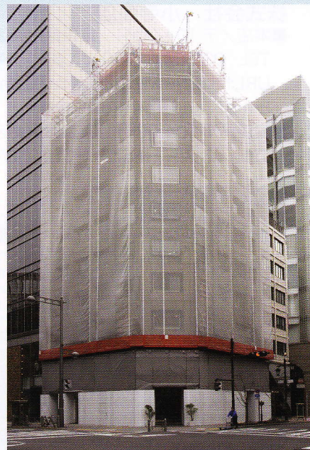
3・11 依頼、銀座ではあちらこちらで耐震工事が行われている。
